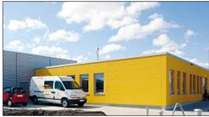
Der Erweiterungsbau der FDS verfügt über eine Fläche von über 1.000 Quadratmetern.
